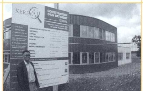
Les salariés de Keréval intégreront fin septembre 500 m 2 de nouveaux locaux construits à Thorigné-Fouillard près de Rennes.
